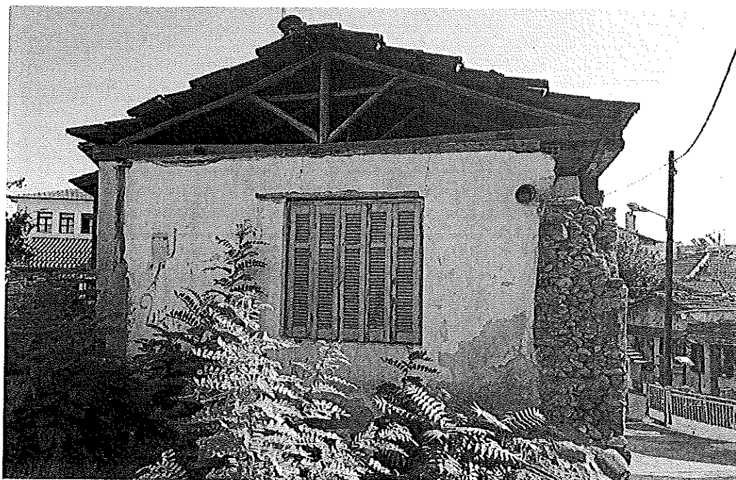
Φωτ. 6 Δυτική όψη
