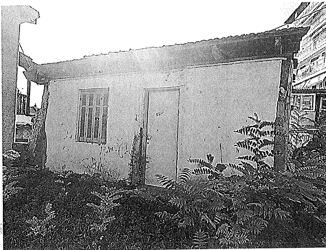
Φωτ. 7 Βόρεια όψη
